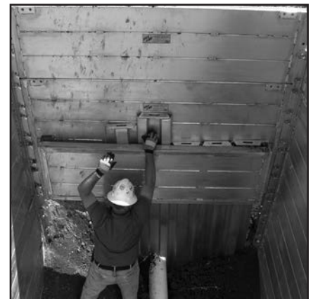
Build-A-Box con cuatro lados, bastidor guía para paneles y paneles
