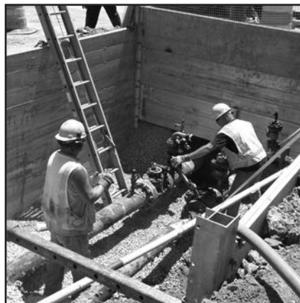
Configuración con tres lados en la que los paneles finales están sujetos a los postes esquineros a una altura de 12 pulgadas (305 mm)
