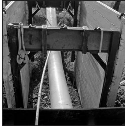
Configuración con dos lados, arcos y postes esquineros de longitud máxima
