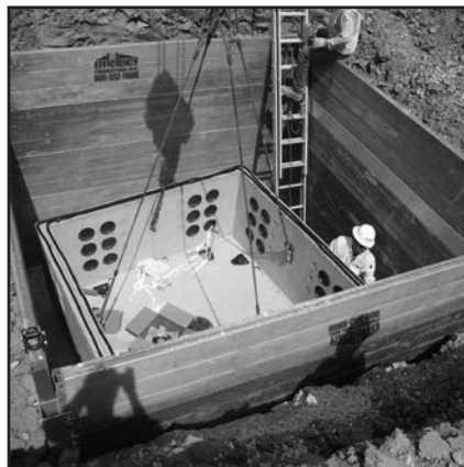
Configuración extensa con cuatro paneles y postes esquineros seccionales
