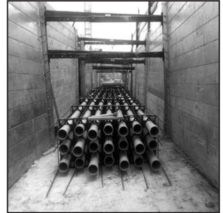
Serie de unidades Build-A-Box con dos lados que protege un conjunto de tuberías largas
