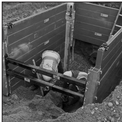
Configuración con tres lados y codales telescópicos, sin panel inferior
