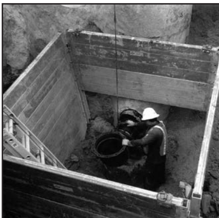
Configuración con cuatro lados y postes esquineros seccionales, sin panel inferior
